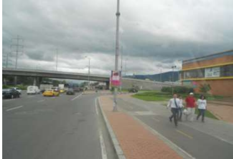
FOTO 1. ELEMENTOS INSTALADOS SOBRE POSTE EN LA CARRERA 45 CALLE 172 del 18-01-2014
